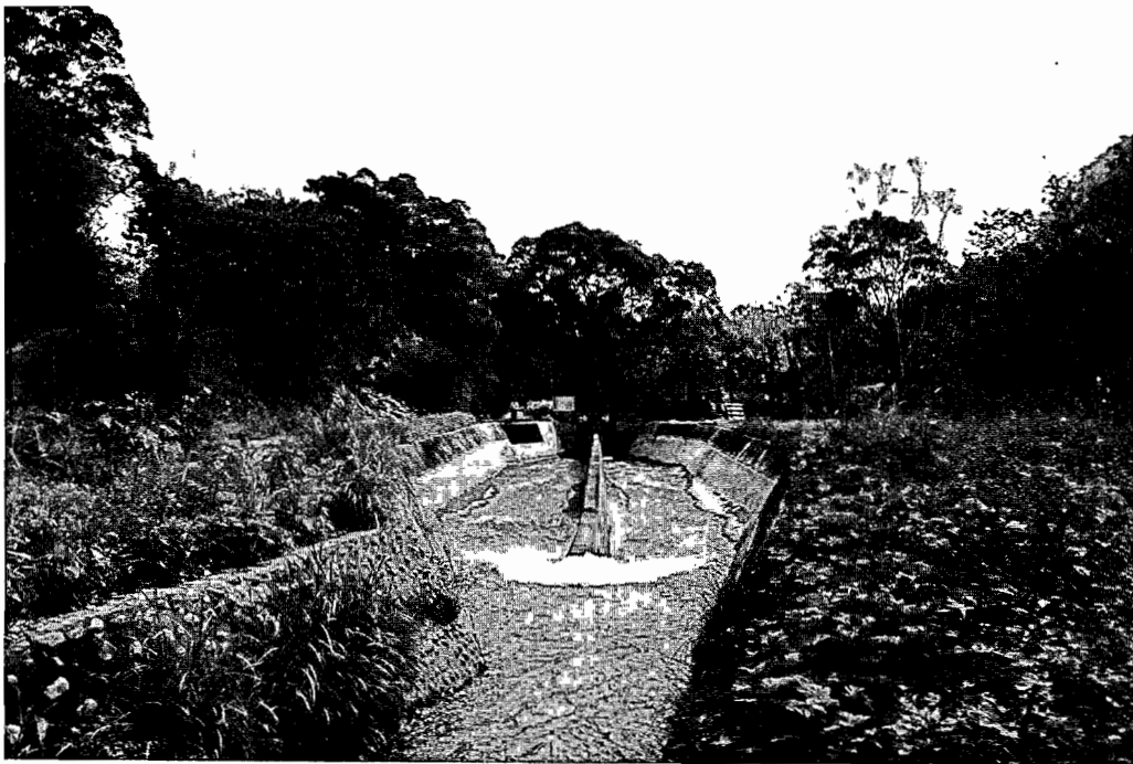
知本圳進水口全景長七〇公尺，寬十五公尺
