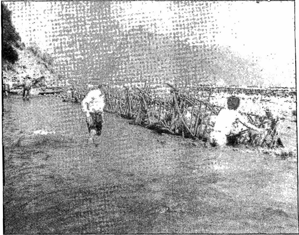
臨時攔水竹筴施工情形
